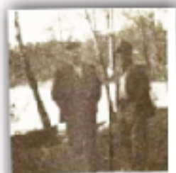
Vägbasen och partifogden vid Johanneskällan
